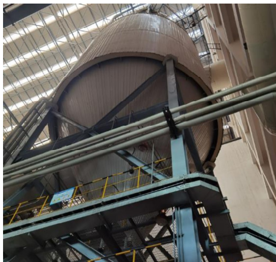
旋转喷雾反应塔
