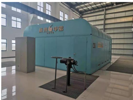
汽轮机隔声罩
