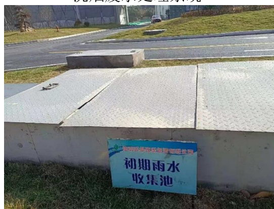
初期雨水收集池
