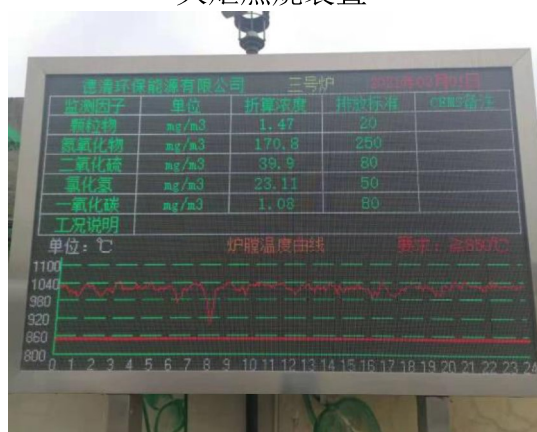
厂区门口废气在线监测数据公示屏
