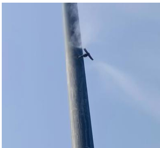
厂区内运输通道高压雾化除臭
