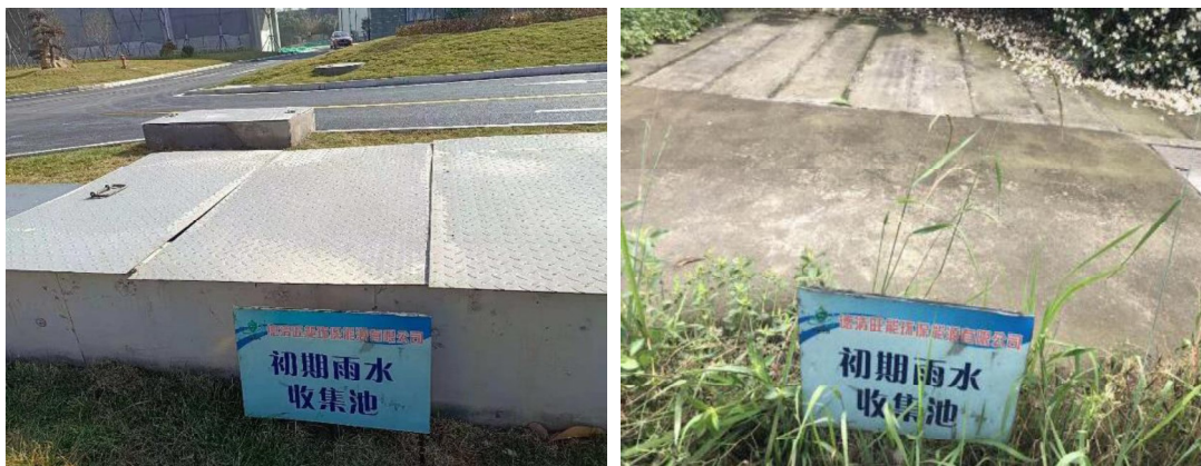
新建初期雨水收集池
